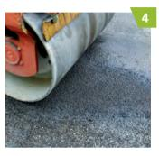
Nach dem Abstreuen mit Splitt erfolgt eine abschlie-Bende Verdichtung mit einer Glattmantel- oder Kombiwalze.
