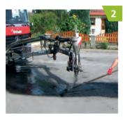
Überhöhte Aufbringung des REPHALT®-Mischgutes, welches innerhalb kürzester Zeit aushärtet
